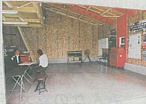
い日本古来の工法である木軸在来工法を採用。木造特有の木痩せによる経年強度不足や、断面欠損が少ないAPS工法を標準装備。もしもの火災時にも梁と柱の継ぎ手強度が落ちにくく、金物が表に露出しないので、スッキリとした内装が楽しめる。車を入れるだけのスペースではなく、自転車・勉強部屋やオフィス、ローコスト住宅として、また、ヨガスタジオ、工房、アトリエ、ウォークインクローゼットなどとしてひとりひとりの趣味やライフスタイルに合わせた空間演出がますます人気を得そうだ。
