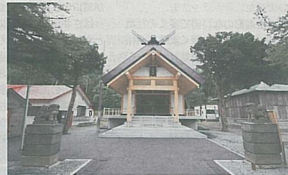
プレカット木組み工法で完成した石山神社 札幌市南区
