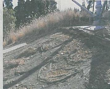
九州電力小丸川幹線の鉄塔下敷地。張芝で地表面の浸食防止に取り組んだが、雨滴で表土とともに張芝も流れ出し、植生マットのみに残った。＝宮崎県西部市
