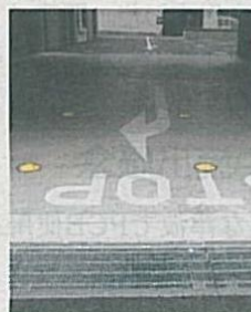
車両通過センサー「PQ-240」の設置例。黄色い突起部がセンサー
